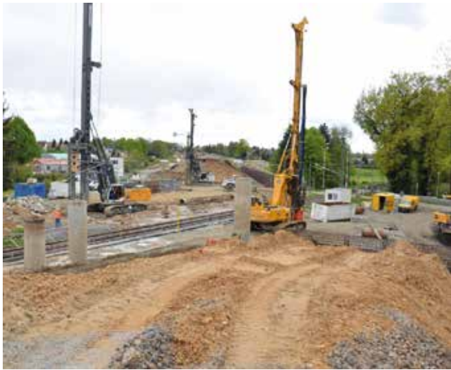
Großprojekt der DB Netz AG, 1. Baustufe 2017–2019, Errichtung der Brückenbauwerke im Bereich der Parkstraße / Jahnkampfbahn Foto: Stadtverwaltung Großenhain
