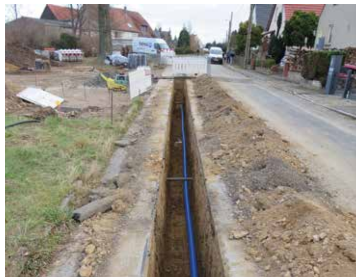
Die Baustelle an der Zschauitzer Dorfstraße.
