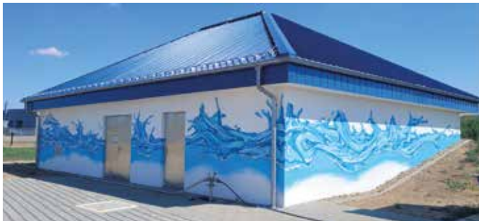
Das neue Bediengebäude am Hochbehälter in Riesa-Weida.
