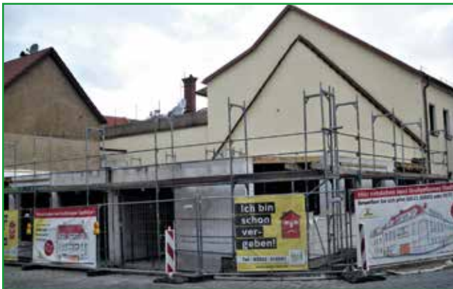
Großenhain, Frauengasse 16, Rohbau der ersten zwei Stadthäuser
