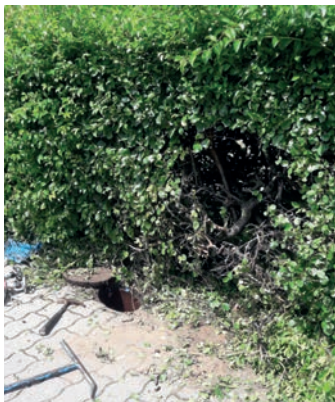
Eine Hecke im Schutzstreifen einer Trinkwasserleitung.
