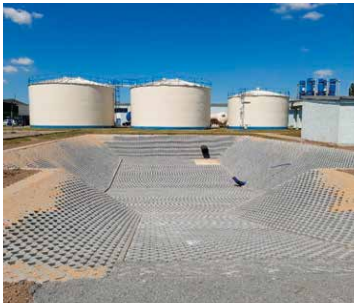
Ein Schlammbecken wurde in diesem Jahr bereits saniert.
