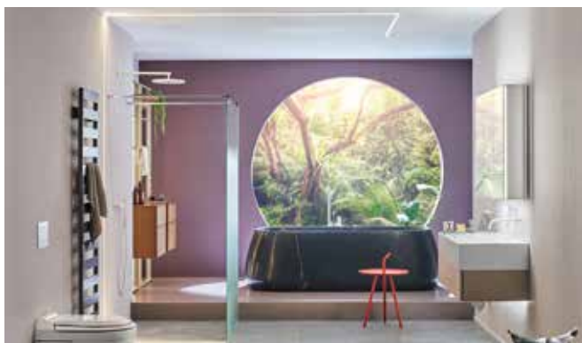
Gut, wenn sie schön aussieht. Besser, wenn sie auch noch funktioniert: Hinter jeder Wohlfühldusche steht eine ausgeklügelte Technik. Foto: Vereinigung Deutsche Sanitärwirtschaft (VDS)/Kermi/akz-o
