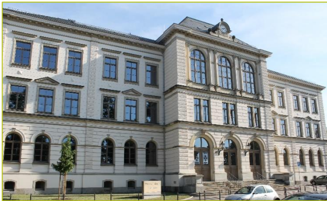
Werner-von-Siemens Gymnasium Großenhain
